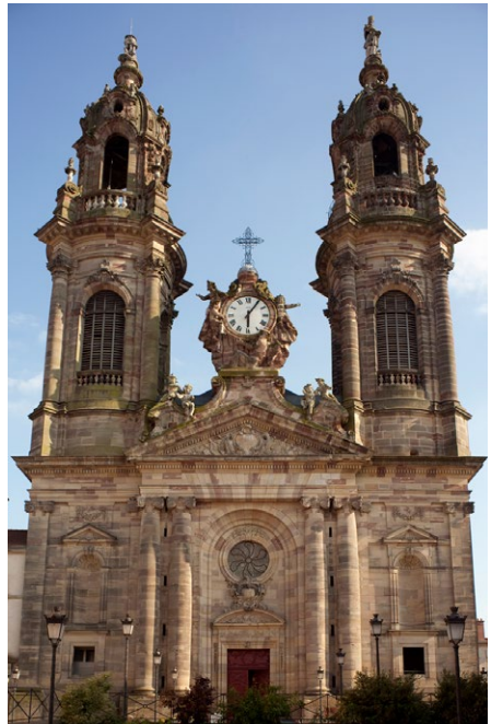
Façade nord de l'église Saint-Jacques avant travaux. Ville de Lunéville
